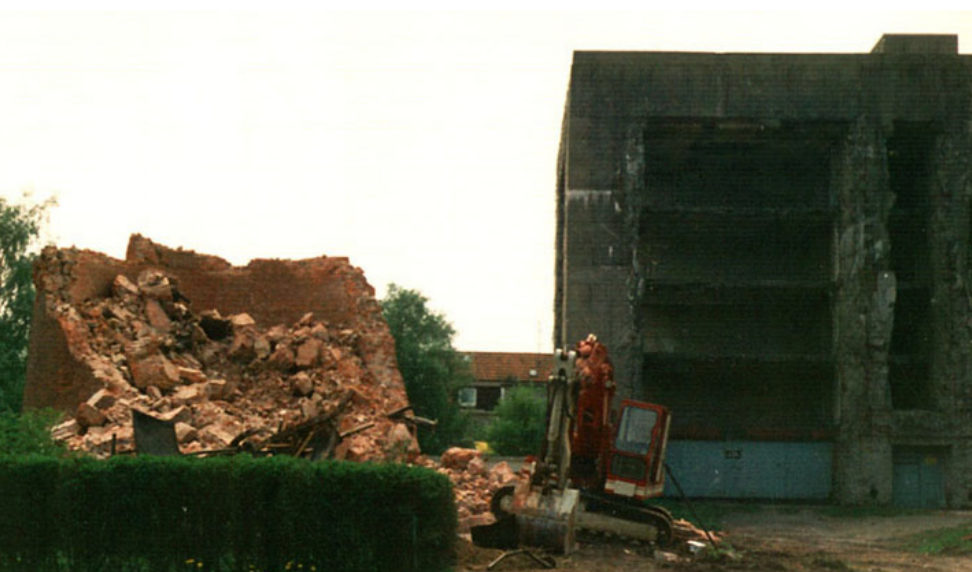
Abriss des Wasserturmes 1979.
